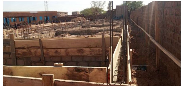
Bauarbeiten für das Lycée in Esther 1
